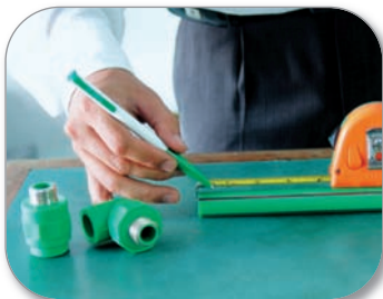
Bước 3: Đánh dấu chiều sâu ở điểm nối Mark the depth of penetration
