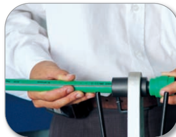
Bước 4: Khi máy hàn đủ nhiệt 260°C (đèn đỏ tắt) đưa ống và phụ kiện vào để hàn. Heat the tool to 260°C (the red light turns off), then push pipe and fitting into the heating tool.
